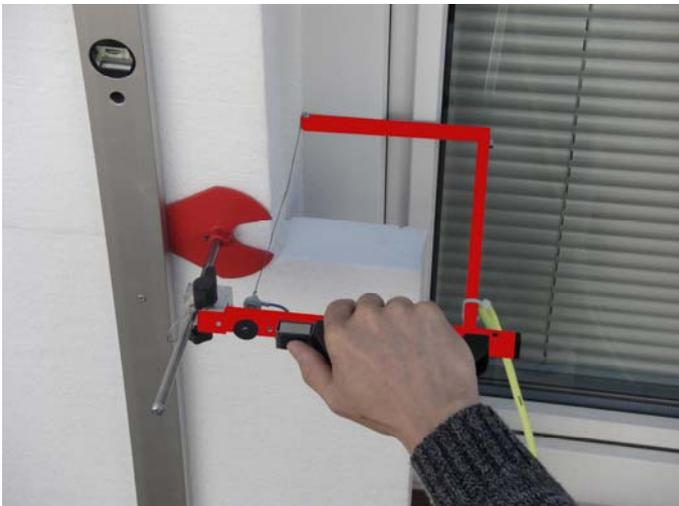
Setzen Sie den Eckenschneider in die Laibung ein und gleiten dann mit dem roten Führungsteller auf dem Styropor herunter. Verwenden Sie dazu eine Wasserwaage, um einen senkrechten Schnitt zu gewährleisten.
